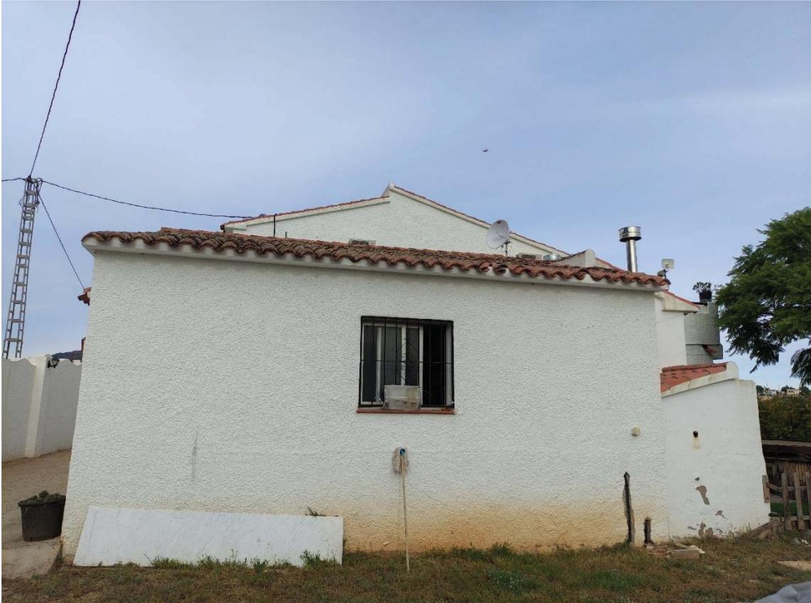
*IMAGEN\_03. Perspectiva de la vivienda 1 tomada de la fachada orientada hacia el sureste. No se aprecia sellado de suelo, hecho que favorece la infiltración de la escorrentía. La carpintería de las ventanas se resuelve mediante aluminio blanco, con rejas metálicas de color negro.*
