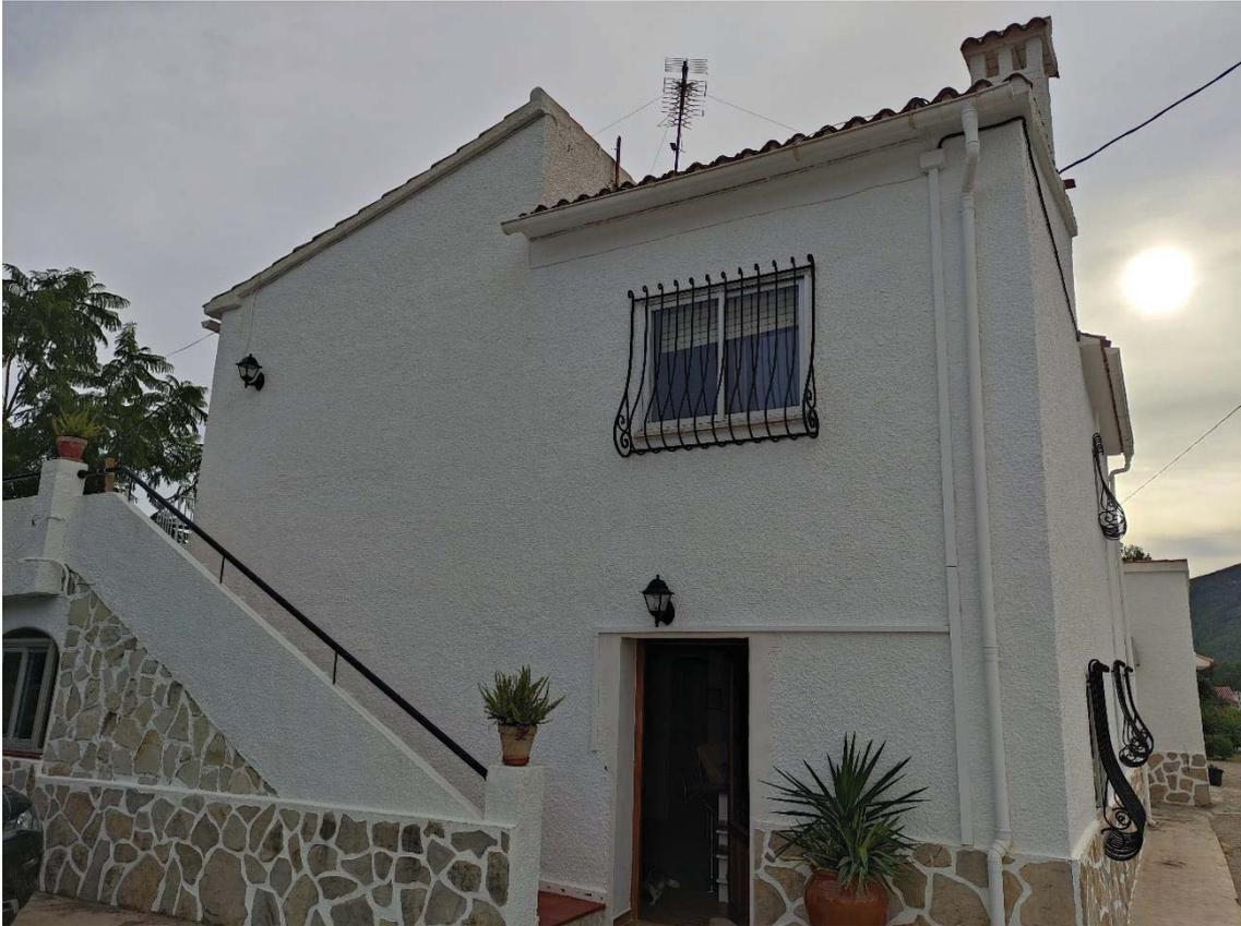
*IMAGEN\_02. Perspectiva de la vivienda 1 tomada de la fachada orientada hacia el noreste. Destaca la inexistencia de sellado exterior de suelo, a excepción de una pequeña acera en esta parte de la edificación, dado que se emplea gravilla, lo que facilita la adecuada infiltración de las aguas de lluvia. La edificación es de dos plantas. La cubierta inclinada se resuelve mediante utilización de teja árabe. El zócalo es de piedra natural.*
